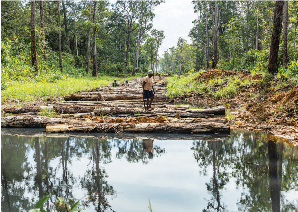
Gambar 7. Ekosistem rawa adat yang rusak total akibat ditimbun menggunakan batang-batang pohon hasil tebangan perusahaan untuk memuluskan akses perkebunan, 17 Januari 2026.
